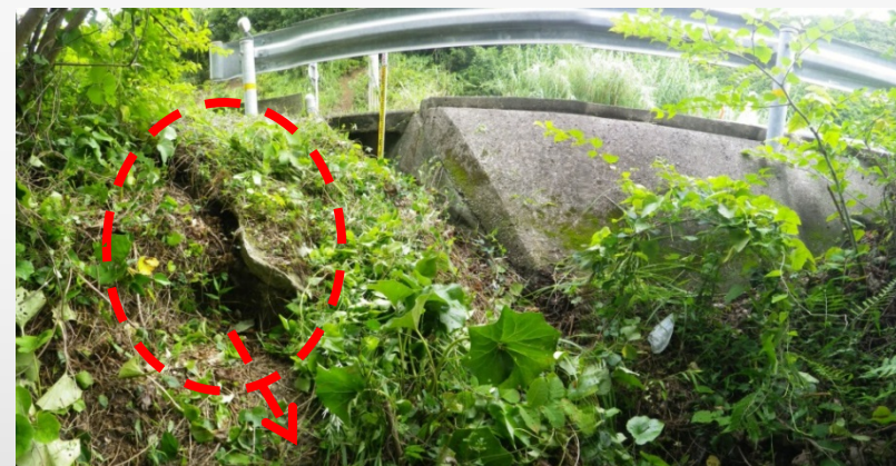
縦排水工裏側の盛土材の流亡
