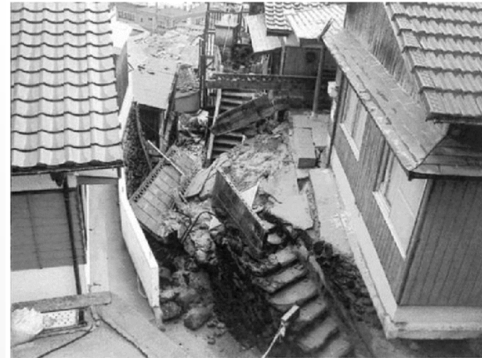
福岡沖地震：擁壁崩壊による道路閉塞
