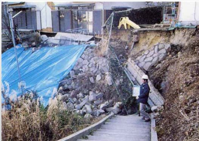
兵庫県南部地震：空石積み擁壁の崩壊
