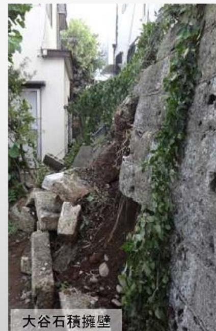
豪雨による石積擁壁の崩壊
