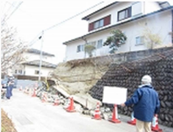
東日本大震災：玉石空積擁壁の崩壊
