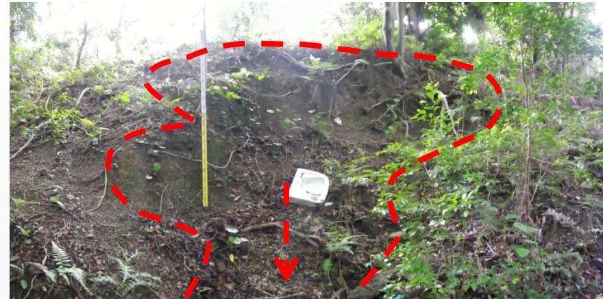
盛土法面に崩壊が発生
