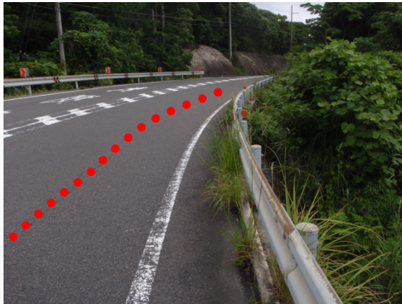
路面に縦断方向へ段差亀裂有り
